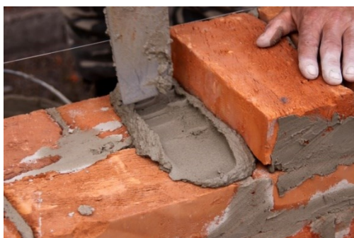
Figura 6 – Aplicação de argamassa de assentamento
