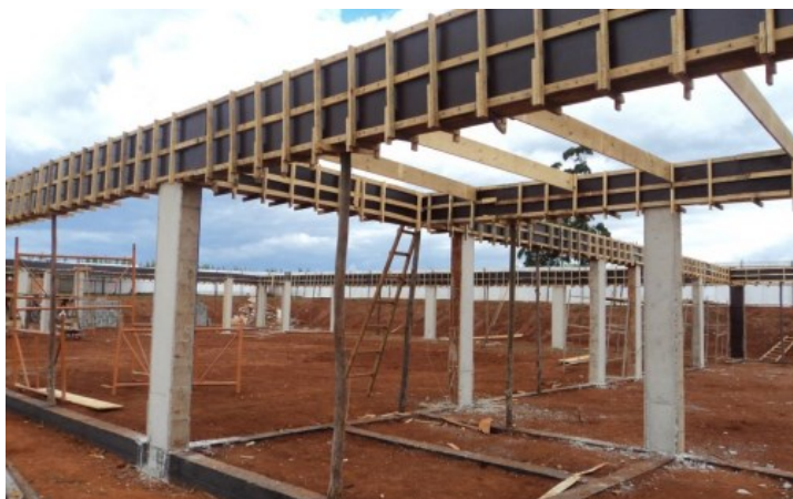
Figura 28 – Viga em concreto armado
