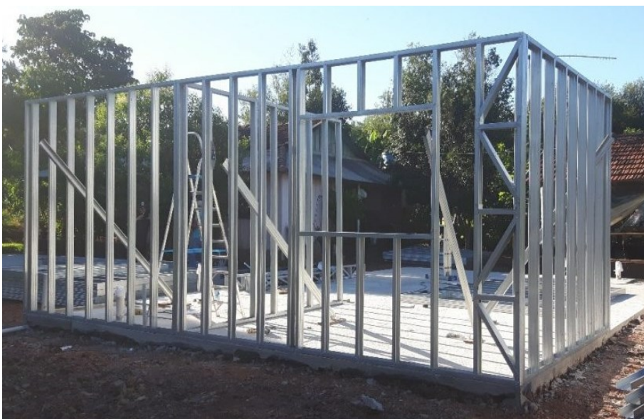
Figura 25 – Painéis em LSF montados sobre fundação radier
