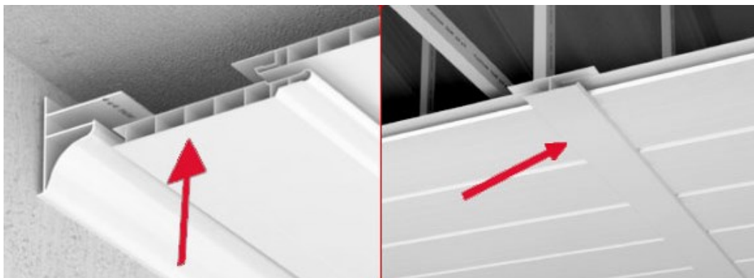
Figura 35 – Instalação de forro de PVC
